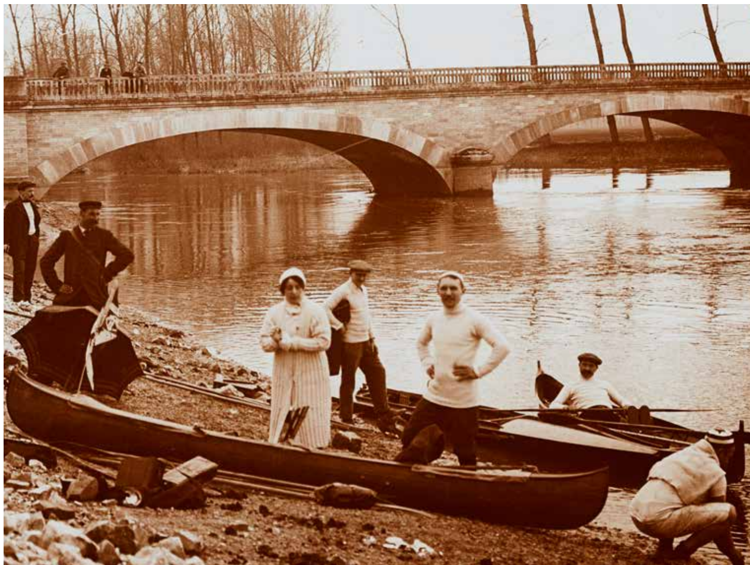
4 – Arrivée au pont de Pogny (Marne).
