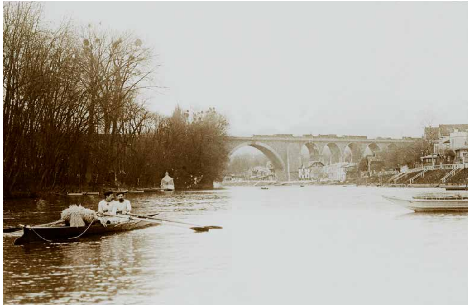
19 – Vers le viaduc de Nogent, Le Perreux-sur-Marne (Val-de-Marne).
