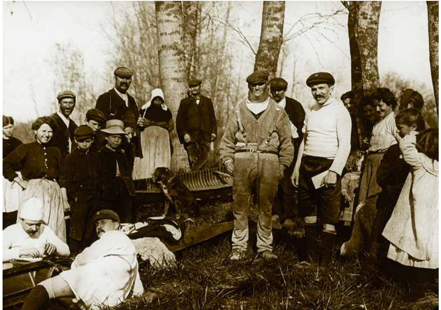
2 - Moeslains (Haute-Marne), réparations.
