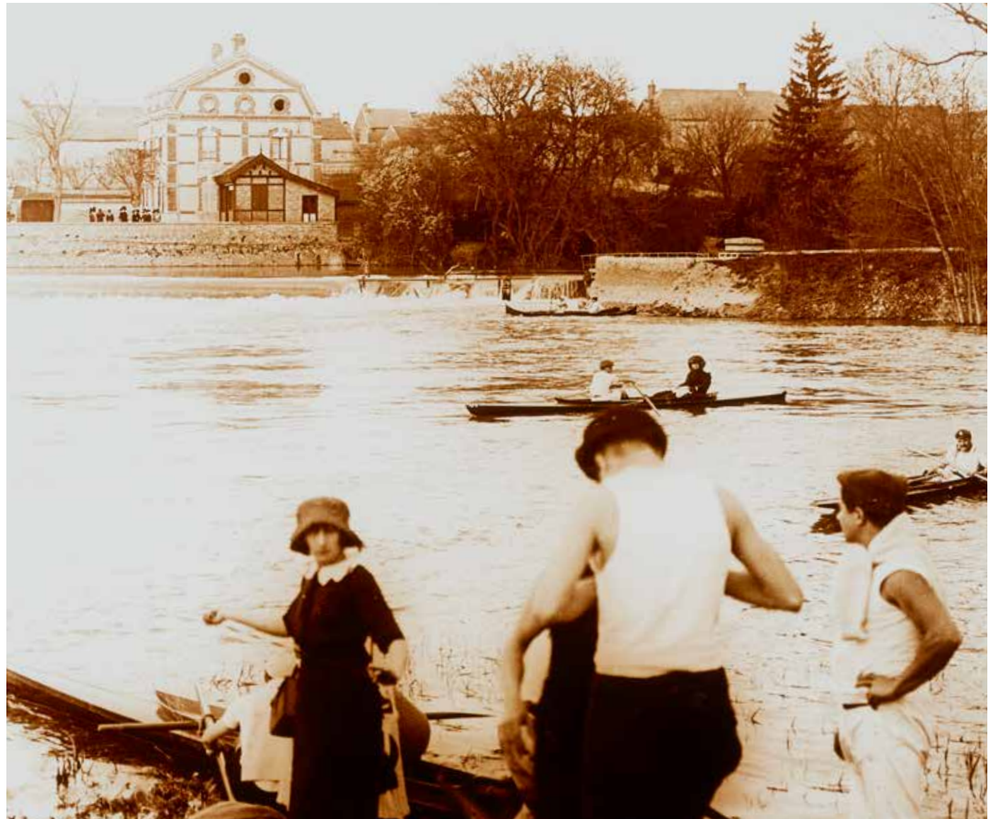
9 – Barrage de Tours-sur-Marne (Marne).
