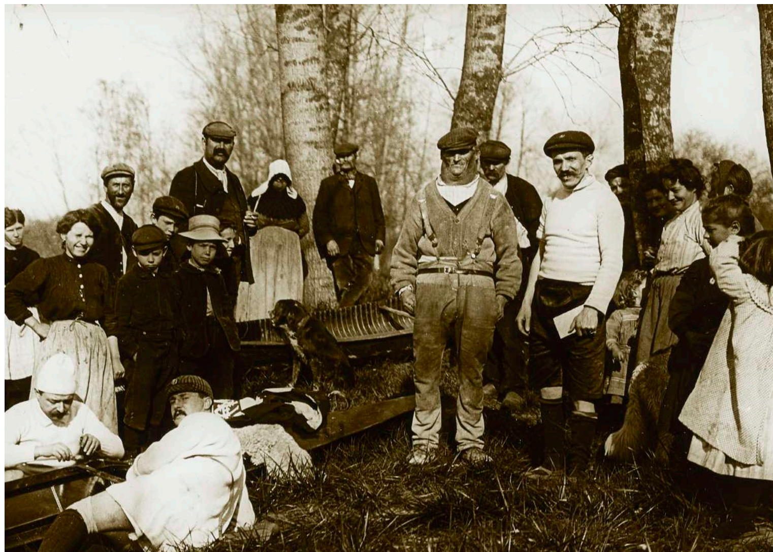
2 – Moeslains (Haute-Marne), réparations.
