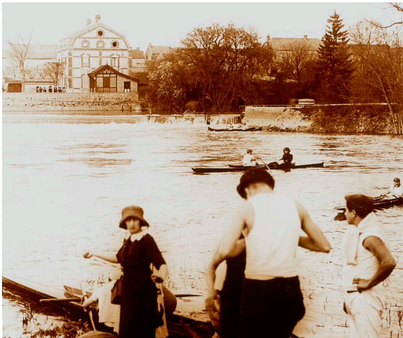
9 – Barrage de Tours-sur-Marne (Marne).
