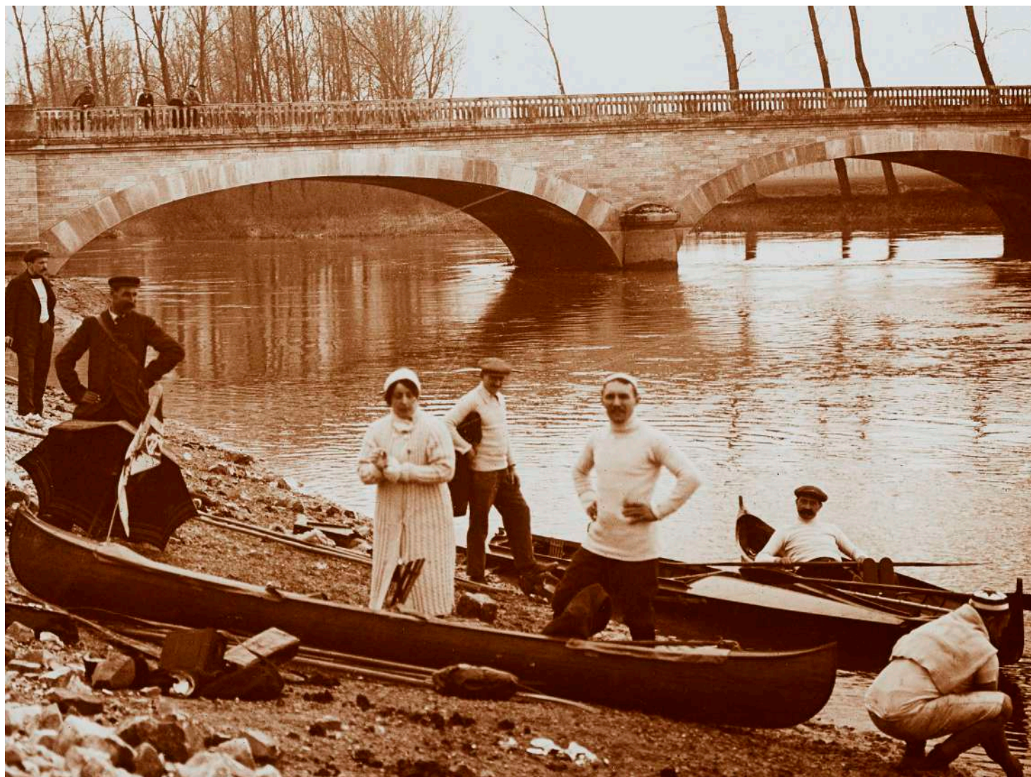
4 – Arrivée au pont de Pogny (Marne).
