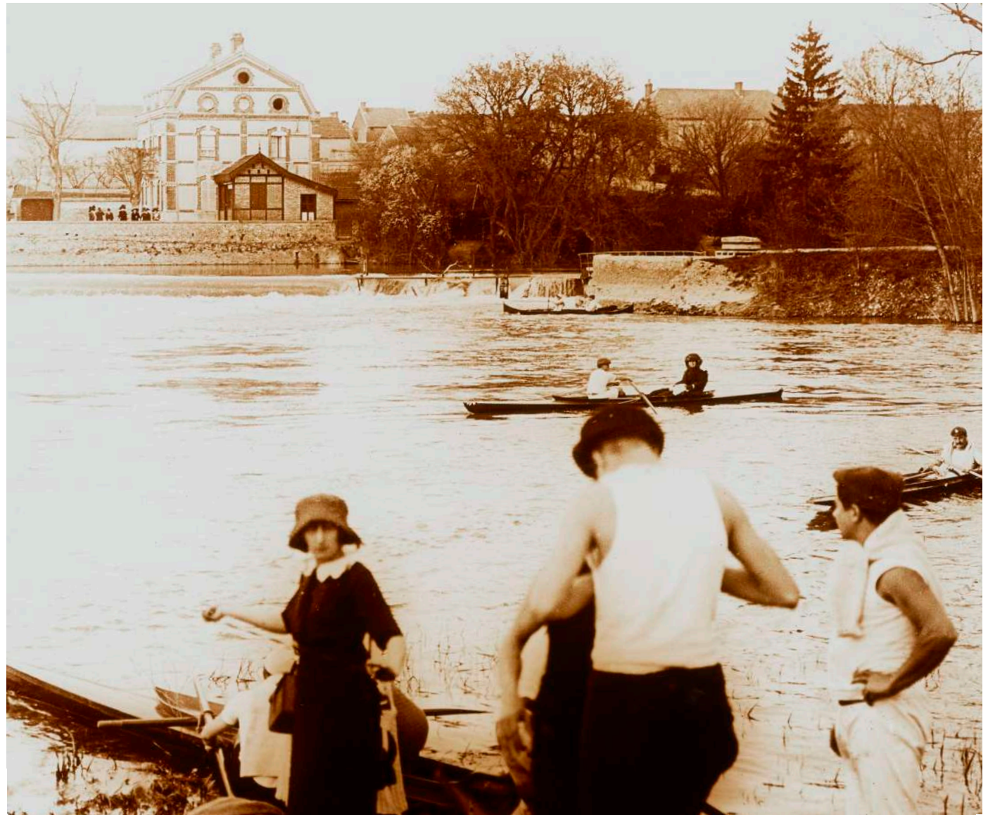
9 – Barrage de Tours-sur-Marne (Marne).
